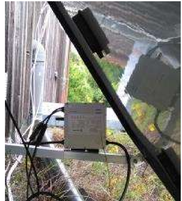
Modulrückseite mit Wechselrichter
