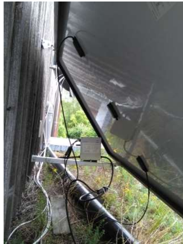
Modulrückseite mit Wechselrichter
